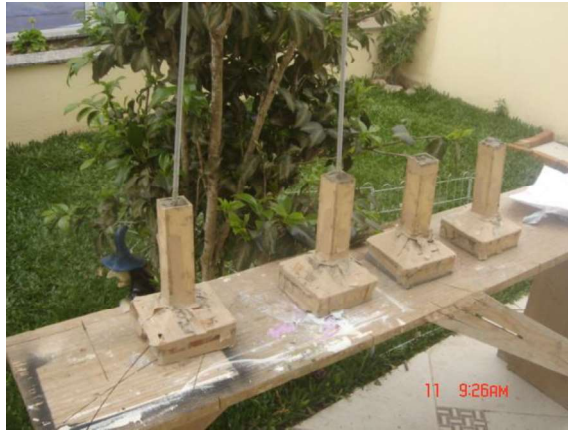
Figura 9: Construção das sapatas.
